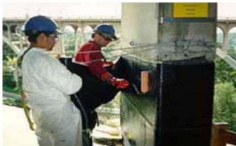
εικ 2.6 Εφαρμογή υφασμάτων σύνθετων υλικών σε υποστύλωμα[15]
