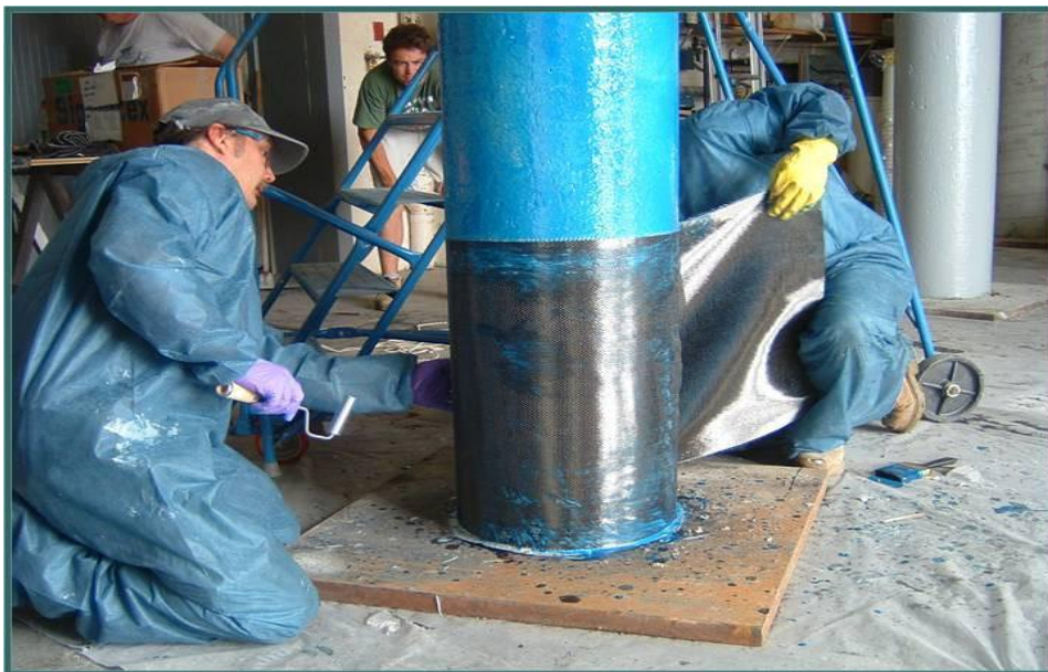
εικ 2.8 Τύλιγμα υποστυλώματος με σύνθετα υλικά[15]
