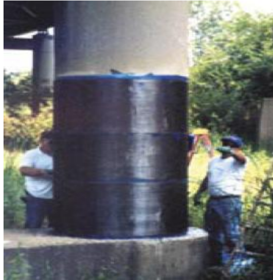
εικ 2.7 Εφαρμογή υφασμάτων σύνθετων υλικών σε υποστύλωμα[15]
